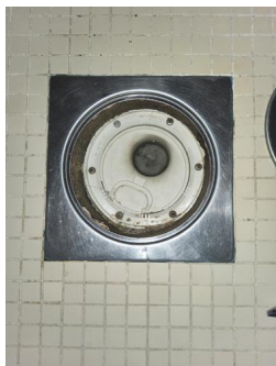
Tettesjiktets tilslutning til sluk - Sluk bad
