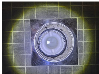
Tettesjiktets tilslutning til sluk - Sluk
