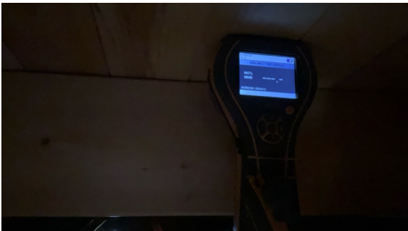
Ved fuktmåling registrerte jeg ikke unormale fuktverdier.
