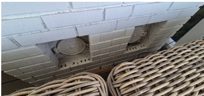
Sotluker på utsiden av veggen
