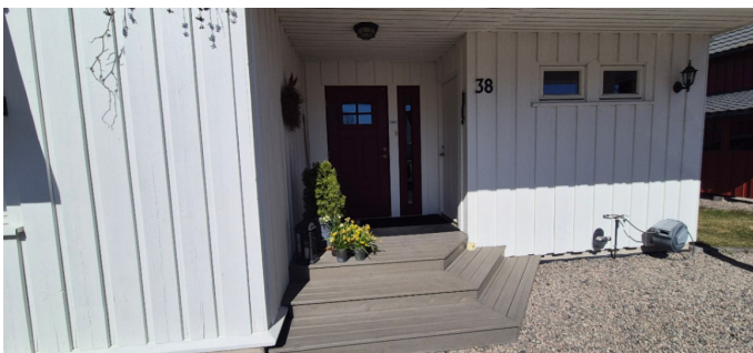
Trapp ved nyere inngang
