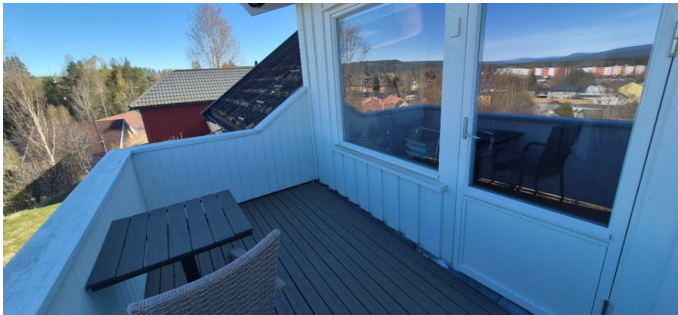
Rekkverk på balkong
