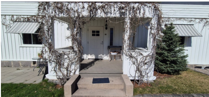
Trapp ved hovedinngang
