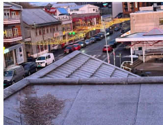
Stedvis taktekke med stålpanner
