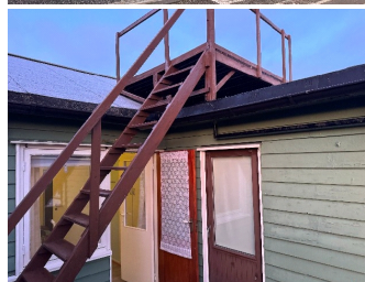
Trapp til takterrasse
