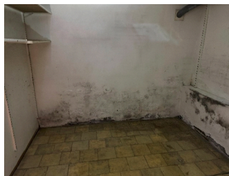
Fuktinntrengning i kjellerrom
