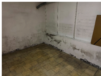
Fuktinntrengning i kjellerrom
