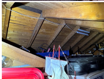
Plassbygget takkonstruksjon
