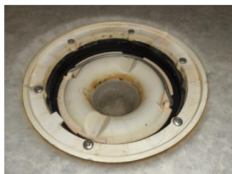
Tettesjiktets tilslutning til sluk - Sluk
