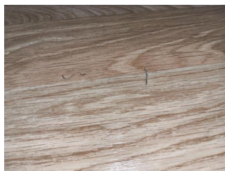
Overflate gulv - Hakk i gulv
