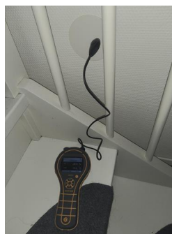
Utført kontroll i tilliggende konstruksjon - Fuktmåling
