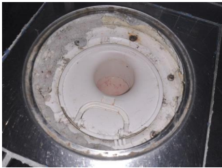
Tettesjiktets tilslutning til sluk - Sluk
