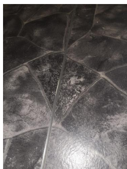
Overflater gulv - Utetthet i beleggsveis
