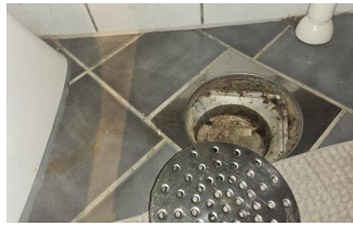
Tettesjiktets tilslutning til sluk - Sluk utenfor dusjsonen.
