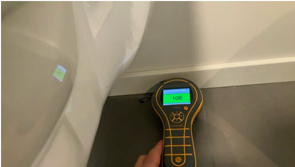
Gulv: Ved bruk av fuktindikator på utsatte steder registrerte jeg ingen unormale verdier.
