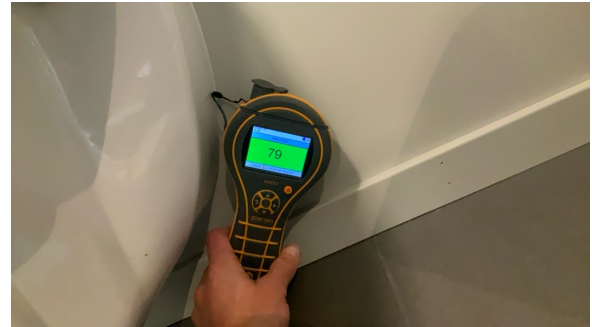
Gulv: Ved bruk av fuktindikator på utsatte steder registrerte jeg ingen unormale verdier.
