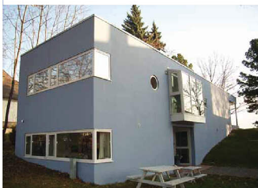
Generasjonsbolig fra 1999, Storhamargata 126. Tegnet av Fosse og Aasen. Byggeskikkpris 2005
