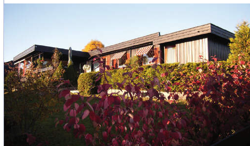
Bilde av et typisk Moelvenhus tatt i 2007
