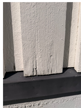
Bordkledningen er slitt og råteskadet i nedre kant.
