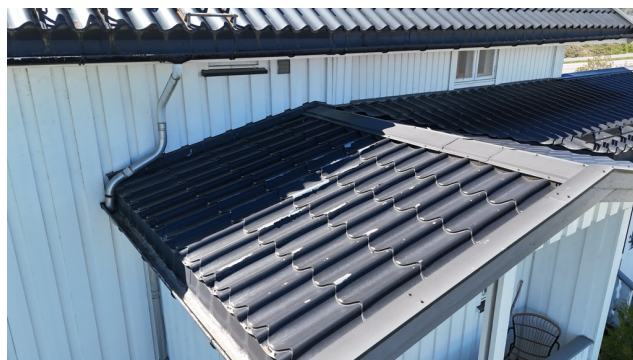
Tak over inngangsparti flasser.
