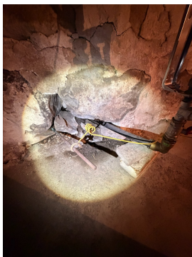
Synlig fuktighet i kjelleren, trekker seg inn under gråsteinsmur.
