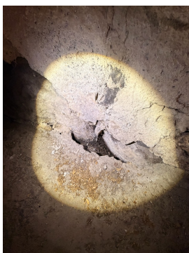
Synlig fuktighet i kjelleren, trekker seg inn under gråsteinsmur.
