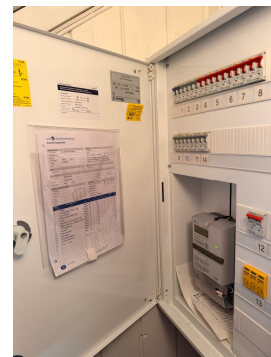
Nytt sikringsskap med automatsikringer i 2011.
