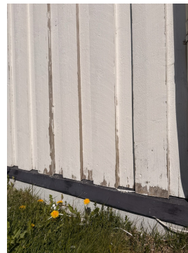
Bordkledningen er slitt og råteskadet i nedre kant.
