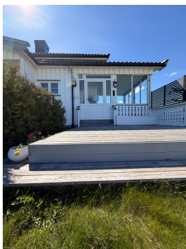
Terrassen har fall mot venstre på bildet.
