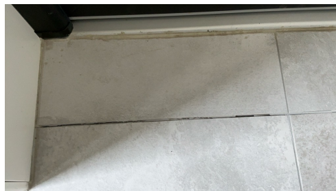
Sprekk i fuge ved ytterdør.
