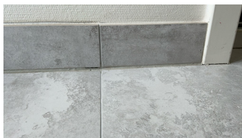
Sprekk i fuge ved ytterdør.
