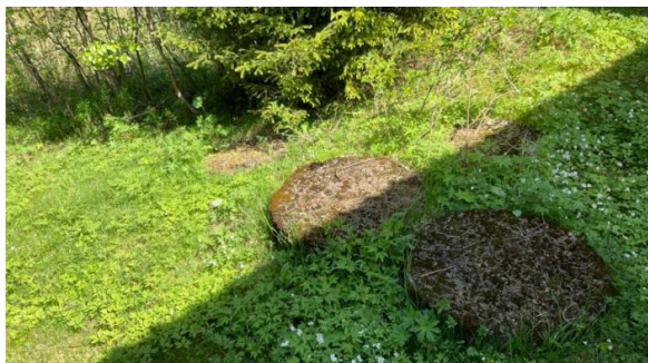
Tre stk slamavskillere i betong.
