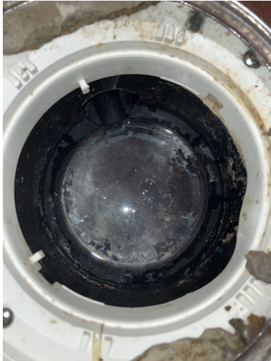
Bilde av sluk.
