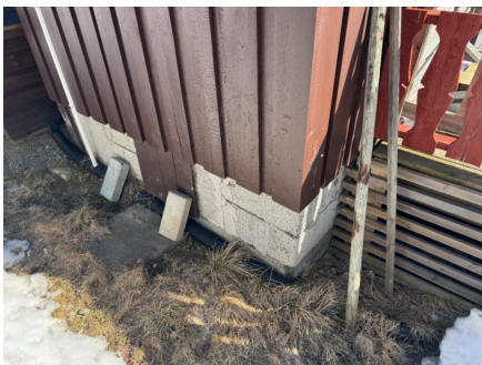
Sprekk i overflater av grunnmur
