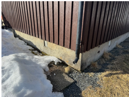
Takvann ført direkte ut på terreng
