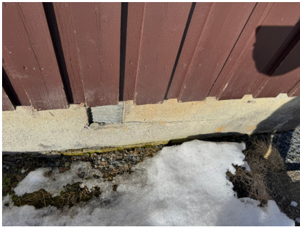
Sprekk i overflater av grunnmur
