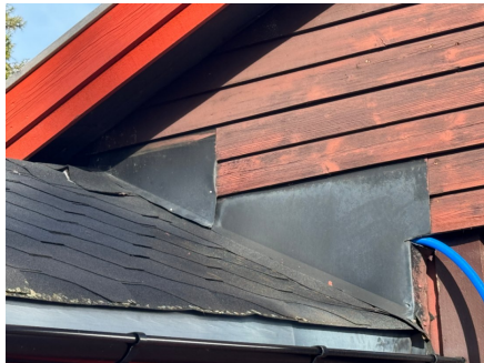
Estetisk ufagmessige avslutninger av takteking
