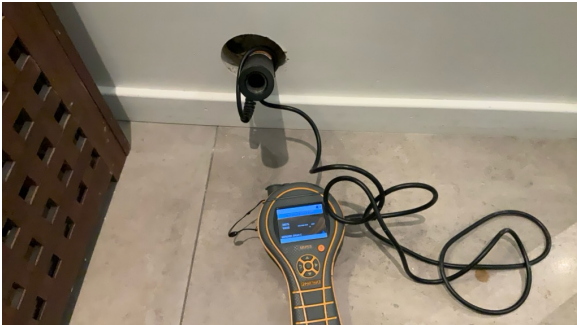
Fuktmåling med pigg mot våtrom: Det ble ikke målt forhøyde fuktverdier ved hulltaking på befaringsstidspunktet.
