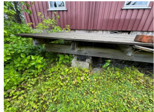
Fundament for terrassen.
