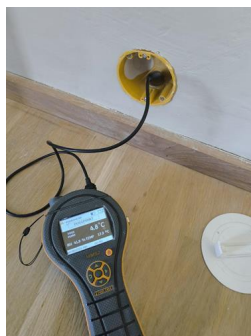
Utført kontroll i tilliggende konstruksjon - Fuktmåling
