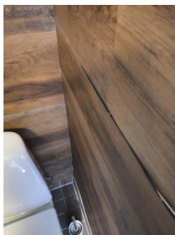
Overflater vegger - Veggoverflater
