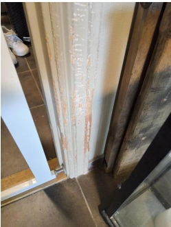
Innerdører - Døren på grovkjøkken
