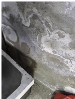
Grunnmur og fundament - Grunnmurens innside.
