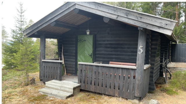
Mønet tak med åser og sperrer. Ikke inspeksjonsmulighet
