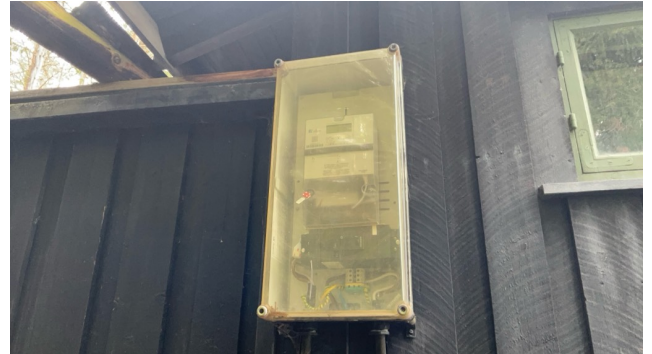
strøm inntak på yttervegg med utvendig måler avlesning.
