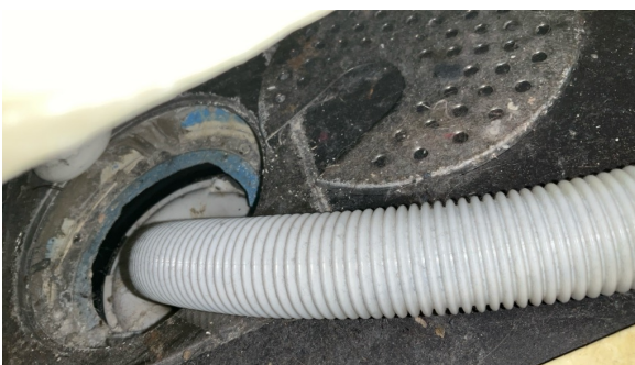
Sluk under befaringsdagen, Synlig membran i sluket.
