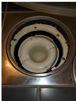
Tettesjiktets tilslutning til sluk - Sluk bad
