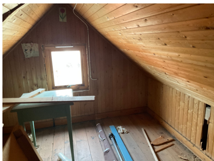
Takkonstruksjon i eldste del av boligen
