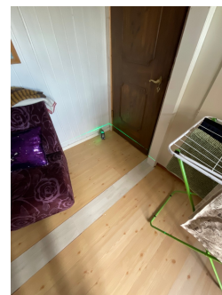
Høydemåling i soverom i 1. etasje
