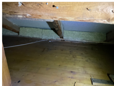
Takkonstruksjon i tilbygget
