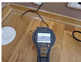
Utført kontroll i tilliggende konstruksjon - Fuktmåling.
