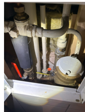
Vannfordeler i innebygd kasse i vegg.
