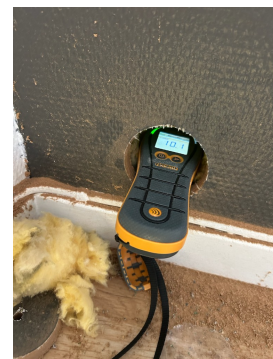
Det er ikke påvist unormale forhold ved fuktmåling i konstruksjonen.
