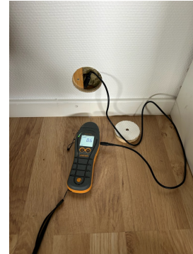
Fuktmåling i tilleggende konstruksjon.
