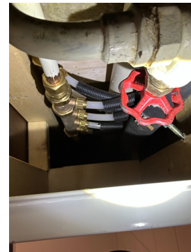
Vannfordeler i innebygd kasse i vegg.
