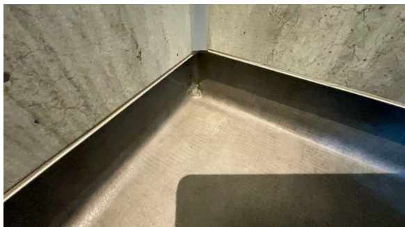
Det er ujevn sveiseskjøt i dusjsonen, som er sikret med fugemasse.
