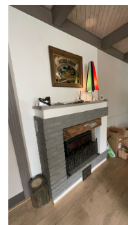
Ildfast plate mangler på gulvet under/foran peisen i 1. etasje.
