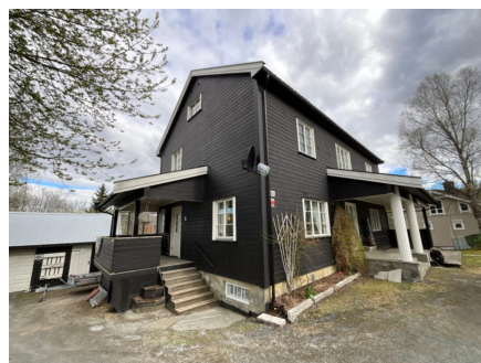
Tretrapp til hovedytterdør og betongtrapp belagt med skifer og pussede opptrinn for balkongdør.
