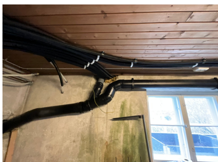
Avløpsrør i plast fra 2018.
