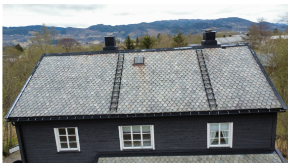
Oversiktsbilde, sørside av hovedtak.
