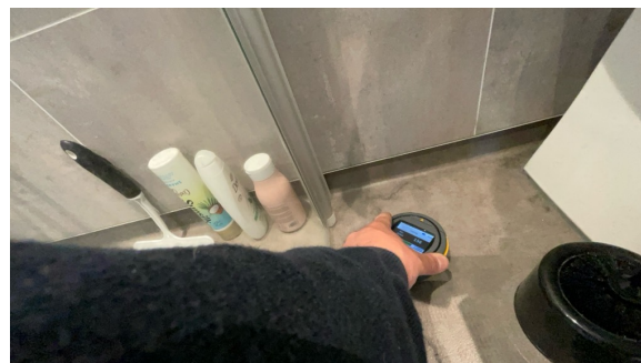
Fuktsøk er utført på gulv og vegg ved dusjvegg/toalett. Ingen forhøyde fuktavvik er målt.
