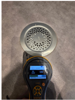
Fuktsøk er utført på gulv ved sluk. Ingen forhøyde fuktavvik er målt
