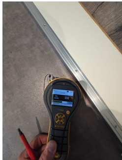
Fuktsøk er utført på gulv ved dør. Ingen forhøyde fuktavvik er målt
