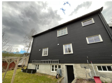
Utvendig oversiktsbilde av veggkonstruksjon.
