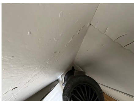
Ikke tilkoblet vedovn 2. etasje.
