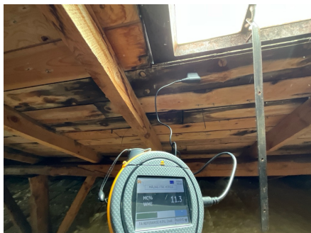
Fuktmåling ved takvindu. Måling viser 11,3% og ingen forhøyde avvik
