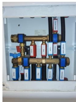
Vannrør - Fordelerskap
