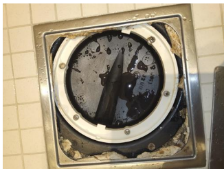
Tettesjiktets tilslutning til sluk - Hjelpesluk
