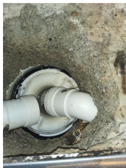
Tettesjiktets tilslutning til sluk - Hovedsluk
