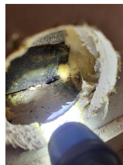
Kontroll i lukkede konstruksjoner - Tegn på mauraktivitet
