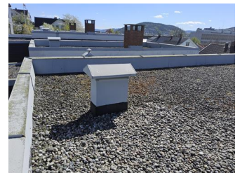
Tagjennomføringer (takhatter o.l.) - -
