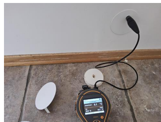
Utført kontroll i tilliggende konstruksjon - -
