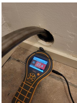
Kontroll i lukkede konstruksjoner - Målinger i vegg
