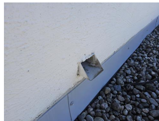
Overløp på flate tak - -
