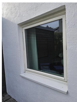
Vinduer og omramming - Vinduer fra 2013
