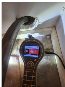
Kontroll i lukkede konstruksjoner - Målinger i påført vegg
