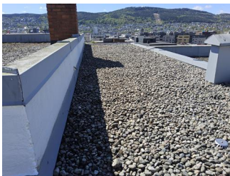
Tekking (med tilhørende beslag) - Tak består av to deler, laveste er tekket i 2022
