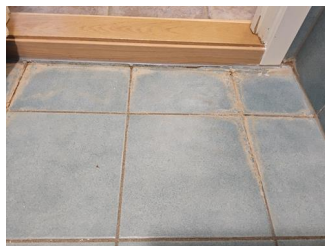
Overflater gulv - Fuger dusj
