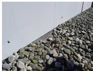
Tekking (med tilhørende beslag) - Ukjent årstall på tekking
