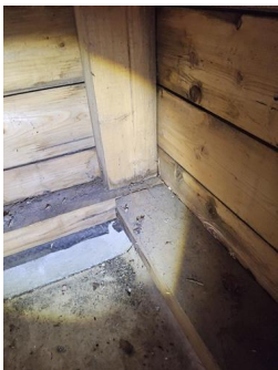
Annet - Tegn på fukttopptrekk på sviller
