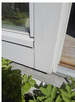
Ytterdører og omramming - Tegn på slitasje terrasseskyvedør nede
