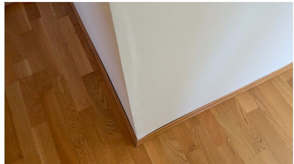
ytterhjørne i gang
