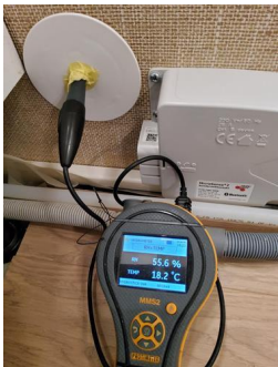
Kontroll i lukkede konstruksjoner - Fuktmåling konstruksjonen rom under terreng.
