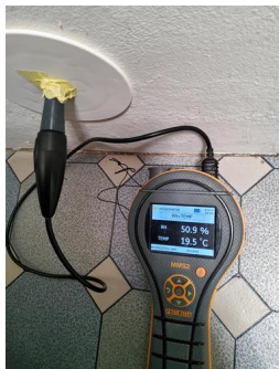
Utført kontroll i tillegg til konstruksjon - Fuktmåling bad.
