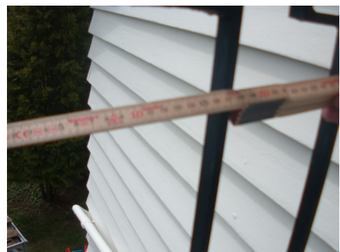
Åpninger i rekkverk er ikke etter dagens forskrift
