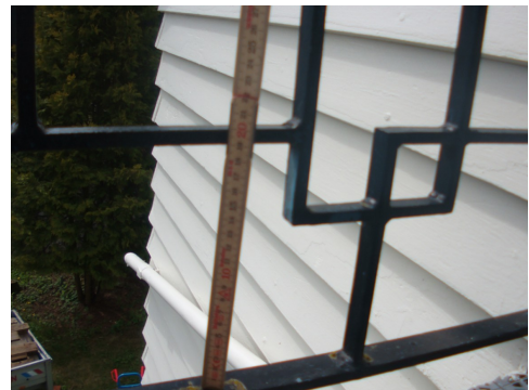
Åpninger i rekkverk er ikke etter dagens forskrift
