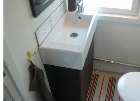
Innredning svellet i bunn av dører
