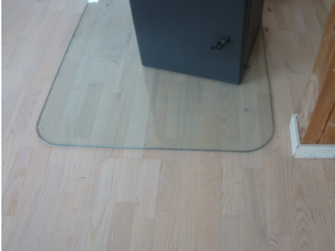
Brannsikker plate under ovn i stue
