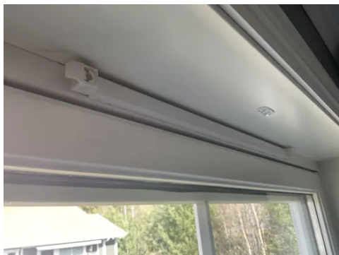
Montert ventiler i øvre del av vinduskarmer
