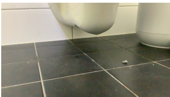
Det er ikke lekkasjevansler fra innebygget sisterner.
