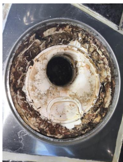
Tettesjiktets tilslutning til sluk - Sluk
