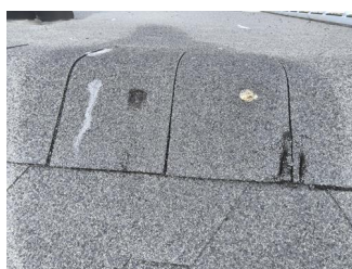
Tekking (med tilhørende beslag) - Skade i shingel
