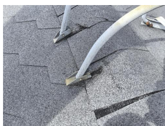
Tekking (med tilhørende beslag) - Skade i shingel ved takstige
