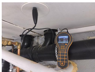
Utført kontroll i tilliggende konstruksjon - Fuktmåling
