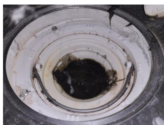
Tettesjiktets tilslutning til sluk - Sluk under dusjkabinett
