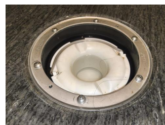
Tettesjiktets tilslutning til sluk - Sluk
