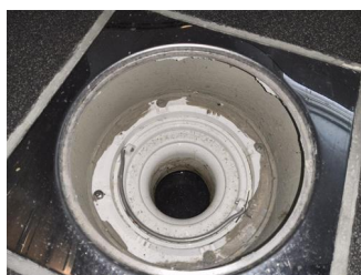
Tettesjiktets tilslutning til sluk - Sluk
