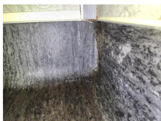
Overflater gulv - Utetthet i beleggsveis
