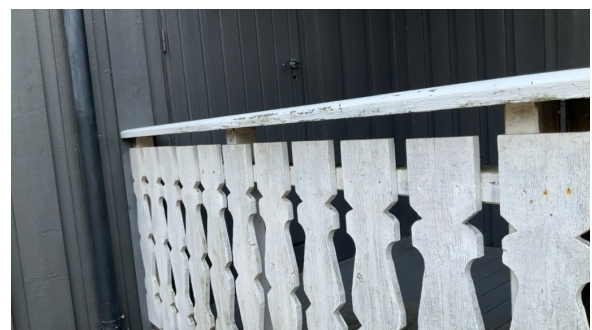
Rekkverkshøyde er lavere enn dagens krav som er 100cm på rette flater og 90cm for trapper.
