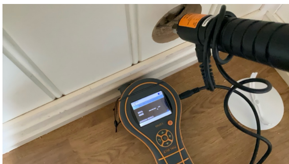
Fuktmåling med pigg mot våtrom: Det ble ikke målt forhøyde fuktverdier ved hulltaking på befaringstidspunktet.
