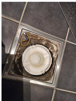
Tettesjiktets tilslutning til sluk - Sluk
