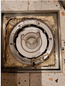
Tettesjiktets tilslutning til sluk - Sluk i dusjsonen.
