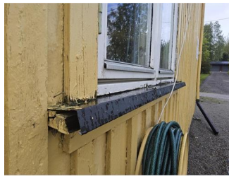
Vinduer og omramming - -
