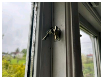
Vinduer og omramming - -
