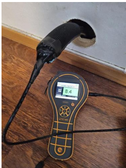
Utført kontroll i tilliggende konstruksjon - Fuktmåling.
