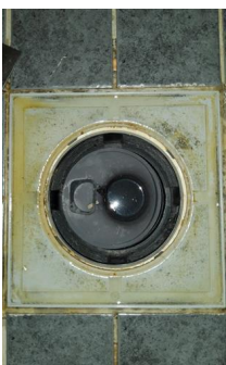
Tettesjiktets tilslutning til sluk - Sluk bad
