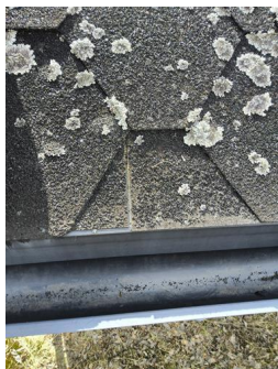
Tekking (med tilhørende beslag) - Utetthet i taktekkingen
