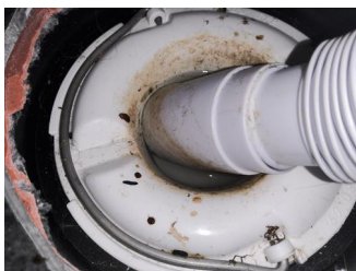
Tettesjiktets tilslutning til sluk - Sluk
