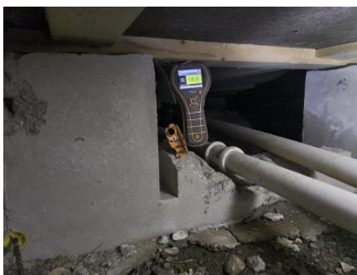
Synlige konstruksjoner - Fuktmåling
