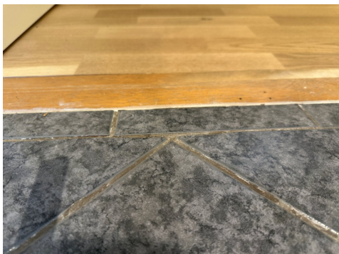
Overgang mot dørterskel.
