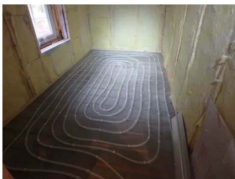
Rørplegg i gulv på uferdig rom i 2. etasje.
