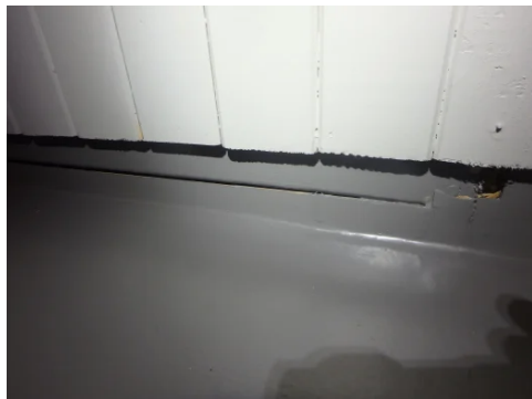
Åpning i membran på vegg.
