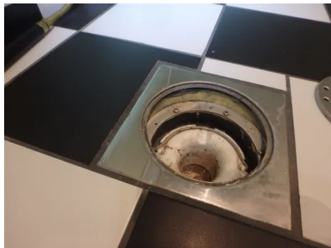
Sluk med synlig membran ved uttak for badekar.
