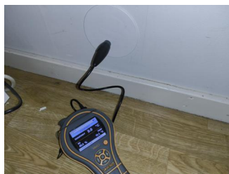
Kontroll i lukkede konstruksjoner - Fuktmåling
