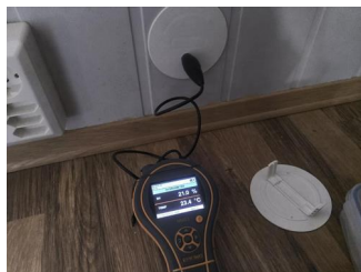
Utført kontroll i tilliggende konstruksjon - Fuktmåling
