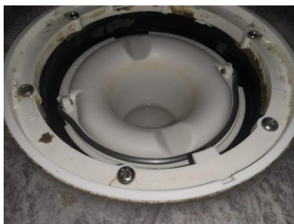
Tettesjiktets tilslutning til sluk - Sluk
