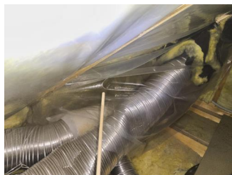
Konstruksjonsoppbygging - Løs damspærre i kneloft
