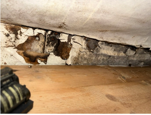
Bilde tatt i overgang mellom skråtak og knevegg på kott.
