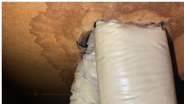
Fuktskjolder ved gjennomføringer i tak.
