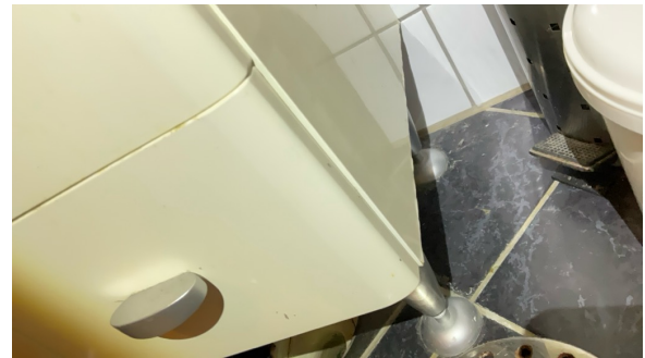
Innredning synlig slitasjepreg og svelling.
