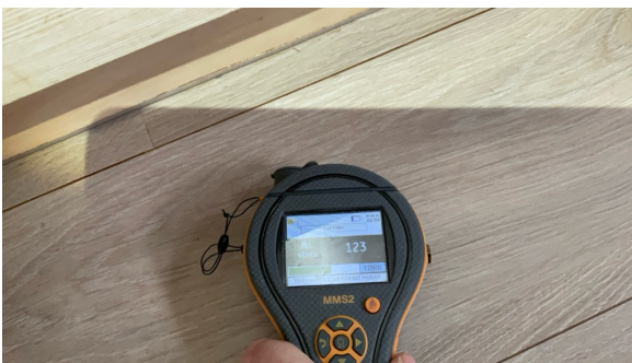
Fuktindikator og ingen unormale avvik.
