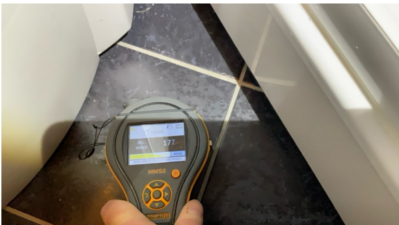
Annen fuktsøk på bad viser ingen unormale utslag på måleindikator ved befarings.
