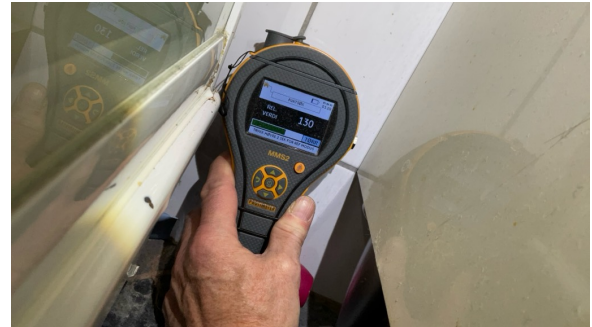
Annen fuktsøk på bad viser ingen unormale utslag på måleindikator ved befarings.
