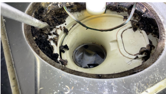
Ned i sluk avdekkes det svekkelser.
