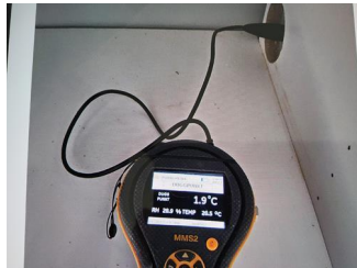
Utført kontroll i tilliggende konstruksjon - Fuktmåling
