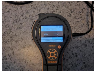
Utført kontroll i tilliggende konstruksjon - Fuktmåling
