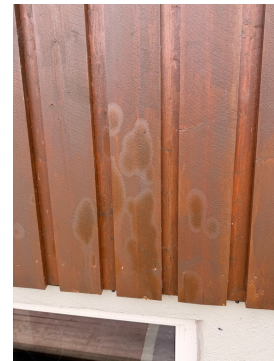
Åpninger opp mellom kledningsbord uten noen form for musetting.
