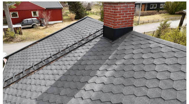
Oversiktsbilde av taktekkingen.
