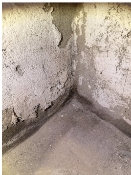
Saltutslag og symptomer på fuktvandring eller kondens på synlige betongvegger.
