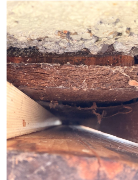
Åpninger opp mellom kledningsbord uten noen form for musetting.
