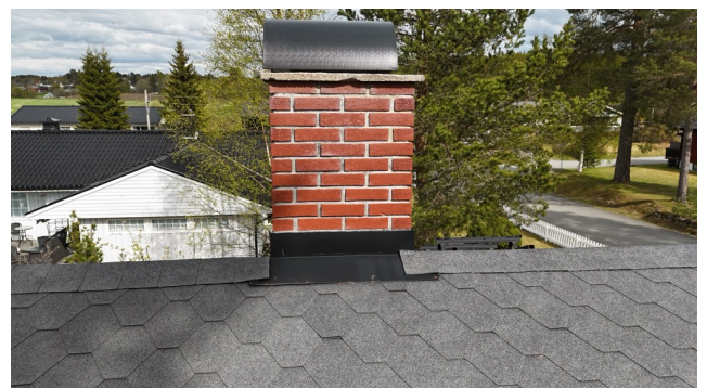
Oversiktsbilde av taktekkingen.
