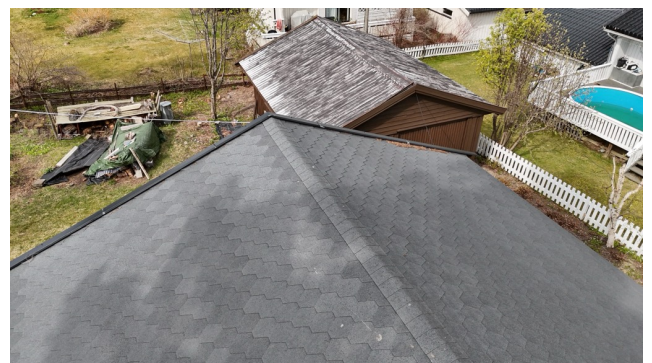
Oversiktsbilde av taktekkingen.
