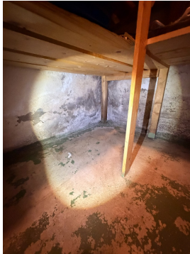
Saltutslag og symptomer på fuktvandring eller kondens på synlige betongvegger.
