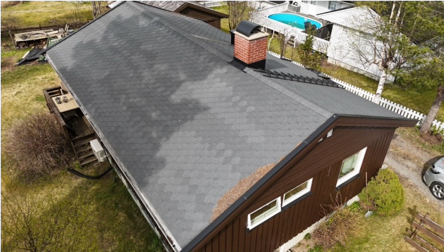
Oversiktsbilde av taktekingen.
