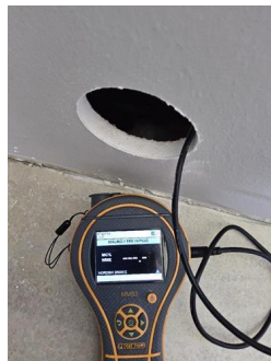
Utført kontroll i tilliggende konstruksjon - Fuktmåling.
