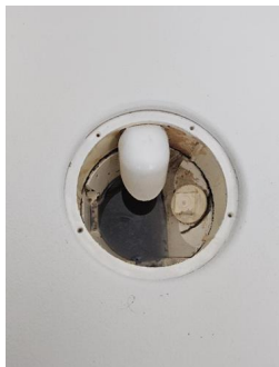
Tettesjiktets tilslutning til sluk - Sluk i dusjsonen.
