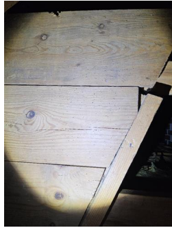
Skadedyr og fuktkrevende insekter - Spor etter borebiller.
