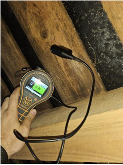
Synlige overflater (taktro, vegger, gulv, o.l) - Fuktmåling i takkonstruksjonen.
