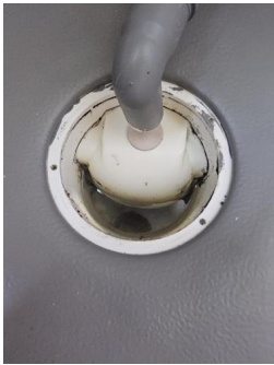
Tettesjiktets tilslutning til sluk - Hjelpesluk.
