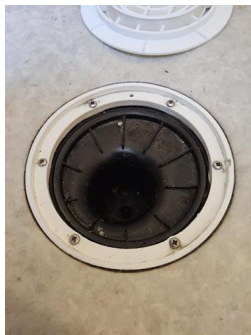
Tettesjiktets tilslutning til sluk - Sluk.
