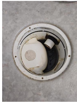
Tettesjiktets tilslutning til sluk - Sluk i dusjonen.
