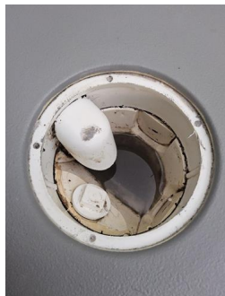
Tettesjiktets tilslutning til sluk - Sluk under badekar.
